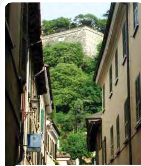
Contrada S. Chiara: scorcio delle mura del Castello Contrada S. Chiara: view of the Castle's walls
